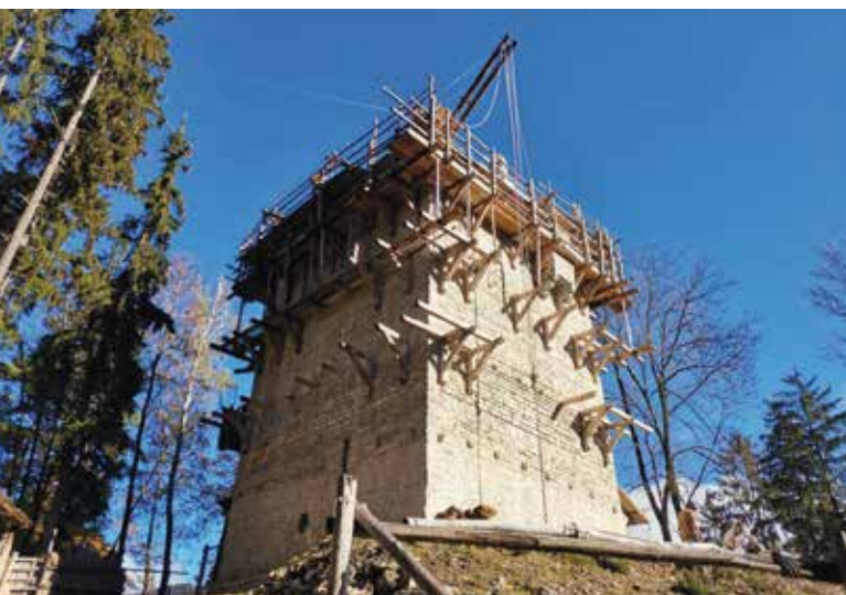
Wohnturm auf der Burgbaustelle in Friesach
